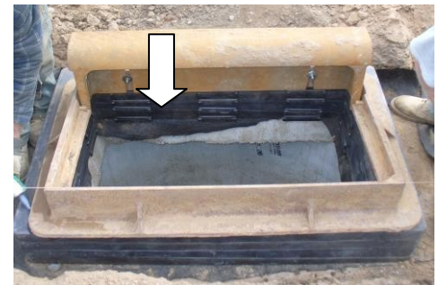
4. Si es necesario desplazar los anillos para lograr la alineación de la colada al bordillo, use una sierra para quitar las lengüetas de bloqueo de la parte inferior del o los anillos según sea necesario. La eliminación de las lengüetas de un lado del extremo del anillo permitirá hasta 2" de desplazamiento. El desplazamiento no debe exceder esta cantidad por anillo. La eliminación de las pestañas de más de un lado permitirá la rotación de los anillos. Nota: El desplazamiento total de todos los anillos no debe exceder los 4" sin que se vierta un collar de concreto para mantener la estabilidad e integridad de la estructura. NOTA: NO SE REQUIERE MATERIAL DE BUTILO entre los anillos
