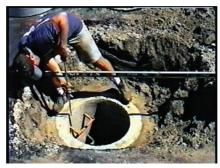
2. Una vez limpia el área de instalación, mida la distancia del cono o losa superior a la explanada final proyectada. Al medir, no olvide deducir la distancia o altura del marco de recubrimiento. Determine la acumulación neta de anillos necesaria para quedar a 1/4 de pulgada de la explanada con el marco de recubrimiento puesto.
