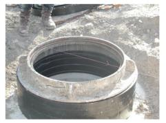
**4.** Una vez hechas las mediciones y escogidos los anillos necesarios, apílelos en seco en el cono o la losa superior. Coloque anillos con declive según corresponda. Con los anillos apilados en seco, coloque la pieza fundida del marco de recubrimiento sobre el conjunto y revise que la altura y el declive coincidan.
