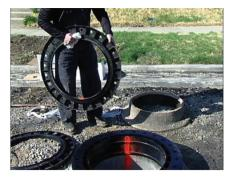
**9.** Repita los pasos anteriores de ensamblaje para cada anillo adicional, aplicando una capa de sellante y colocando los anillos uno sobre otro alineando la línea pintada
