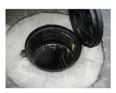
**13 b.** En este puno, la instalacion de los anillos de ajuste de Ladtech está casi completa El paso final es presionar hacia abajo con una pala retroexcavadora comprimiendo el caucho de bulilo enntre todos los anillos. LA INSTALACIÓN ESTÁ LISTA!!
