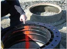
**5.** Cuando el conjunto esté instalado y tenga la altura y declive deseados, marque toda la pila con una línea vertical de pintura en lata. Una vez hecha la línea, desarme el conjunto.
