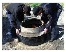
**11.** Ahora hay que instalar el marco de recubrimiento. Antes de instalarlo, aplique una capa de 3/16 a 1/4 de pulgada de sellante de butilo aprobado o una cuerda de 3/8 de pulgada de ASTM C-990 en la parte superior del último anillo. Aplique el sellante en un lugar en que haga contacto con el marco en todos los 360 grados. De ser necesario, puede aplicar dos capas de sellante.
