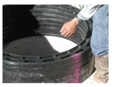
**3.** Ya que tiene las mediciones preliminares, deberá determinar la mejor combinación de alturas de anillo para lograr el ajuste necesario para su instalación específica. Si el terreno no es plano, use anillos con declive para compensar la diferencia.
